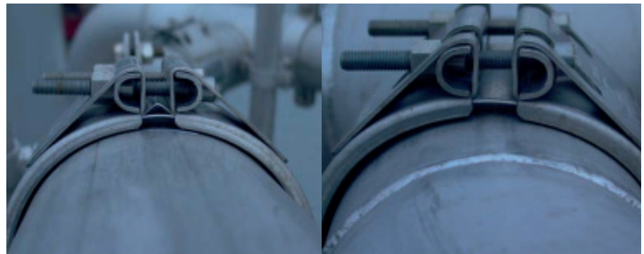
Bild 1: Auf der linken Bildhälfte ist eine Leckagestelle an einer Rohrverbindung einer Biogasleitung infolge einer fehlerhaften Montage zu erkennen. Rechts sieht man eine ordnungsgemäße und gasdichte Verbindung.
